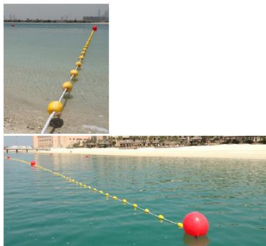
Exemplo da sinalização da zona de banhos
